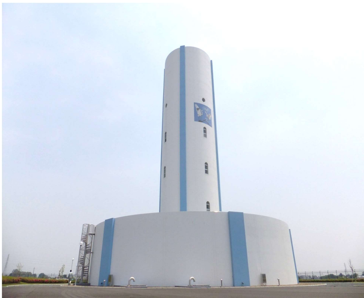
しらすぎ配水場
