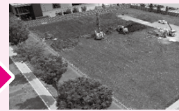
5月には、建設地に仮囲いを設置しました。まずは、基礎工事として建物に傾いたり沈んだりしないよう、地盤補強のための柱状改良工事を行いました。
