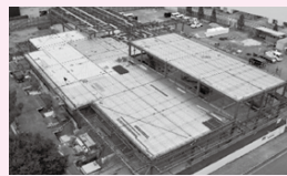
9月には、工場で制作した鉄骨を、現場に搬入して建てていく、鉄骨建方工事が行われました。
