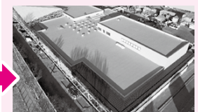
12月には、外壁工事が完了し、内部では天井や壁の下地取付工事が行われています。また、こどもひろばに屋根がかけられました。
