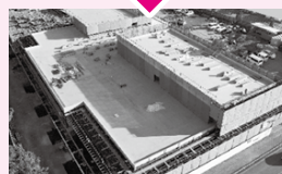
10月には、コンクリート打設が完了し、外壁工事が始まりました。また、以前ウッドデッキがあった場所で、屋根付き広場の工事が始まりました。
