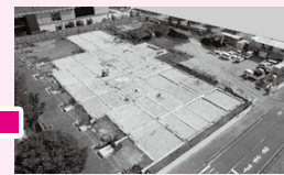
8月には、基礎の埋め戻しが行われ、無事に基礎工事が完了しました。基礎は建物が完成してしまうと見えない部分となりますが、とても重要なため、約4か月の期間をかけ、丁寧に行いました。
