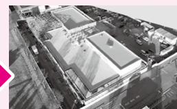
11月には、内装・仕上げ工事が始まり、建具などの取り付けを開始しました。また、こどもひろばのトラス建方が始まりました。
