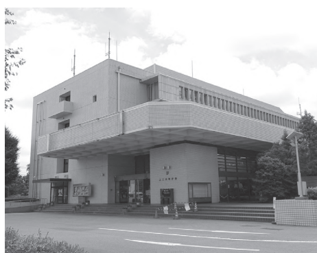
改修工事が行われる役場庁舎
