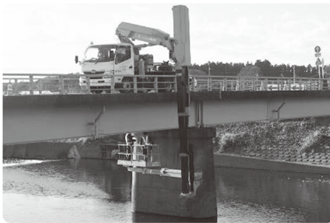
橋梁点検調査の様子
