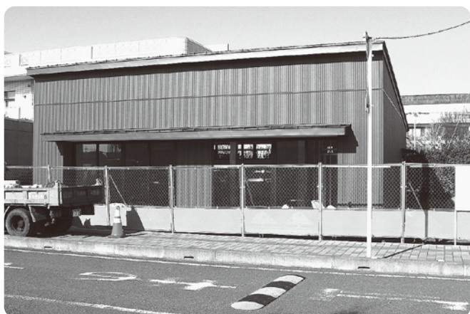
4月の開所に向け工事が進む農産物直売所
