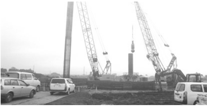
工事が始まったしらさぎ配水場
