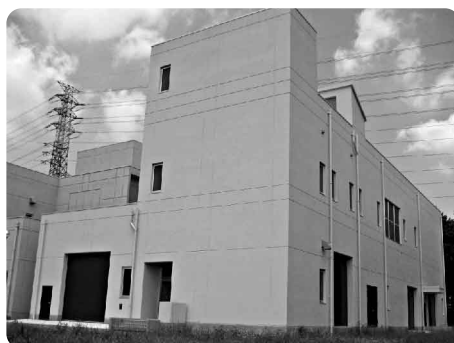
県央下水処理場
