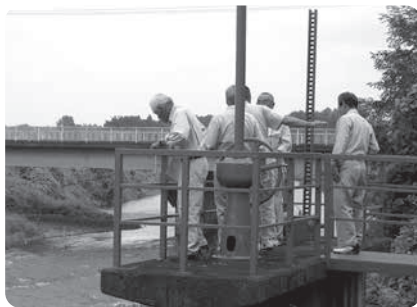
田川排水樋門
