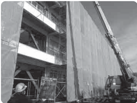
明治中学校耐震補強工事
