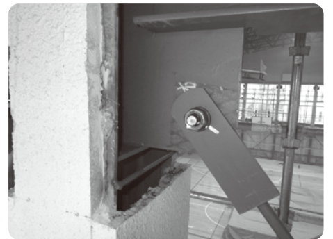
耐震補強(ブレース取付完了)
