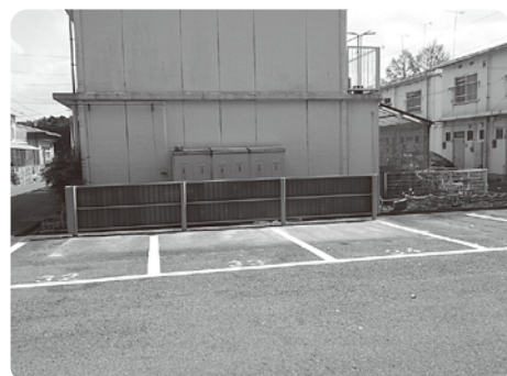
改修された駐車場
