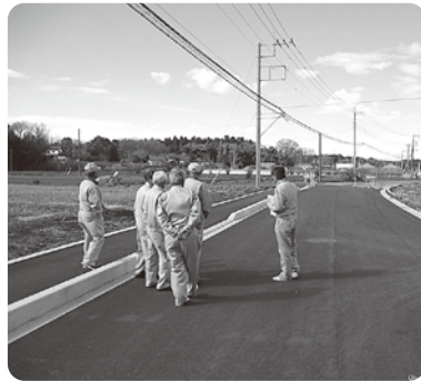
改修された通学路 (大字下神主地内)
