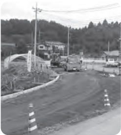
道路工事の様子
