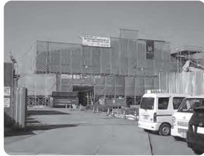
新築工事中の上三川小学校屋内運動場
