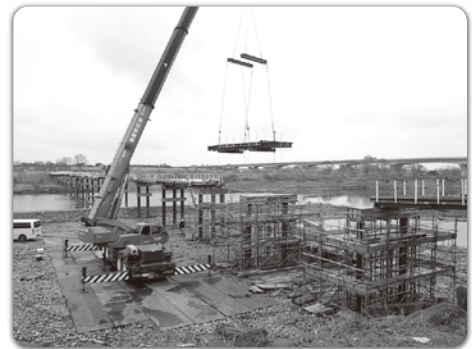
東蓼沼橋復旧作業の様子 (現在、工事は完了しています。)
