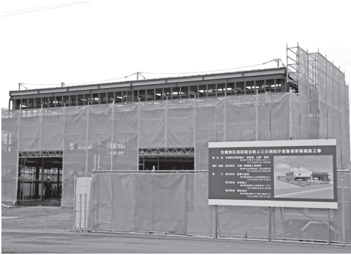
現在建設中の新上三川消防庁舎
