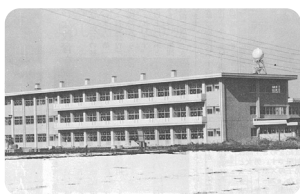
完成した普通教室棟
