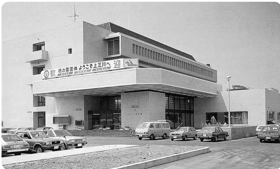
完成直後の役場庁舎
