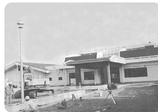
建設中の老人福祉センター
