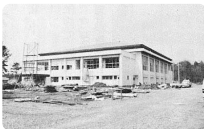
完成直後の体育センター
