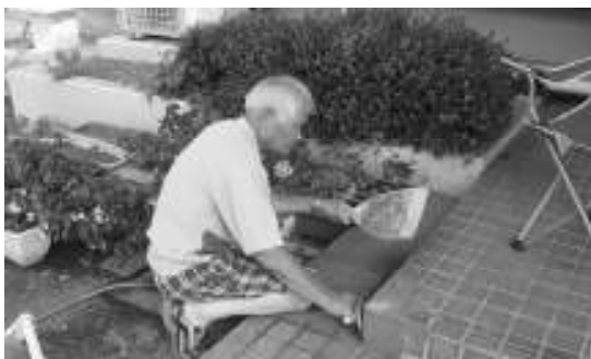
タイルの修繕を行う町商工会工業部部員
