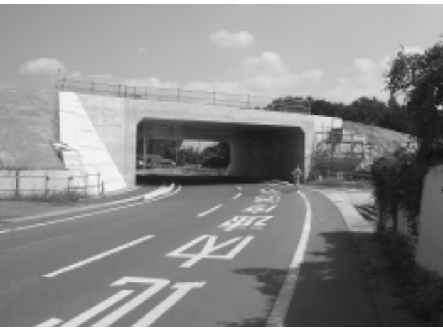
北関東自動車道のボックスカルバート
