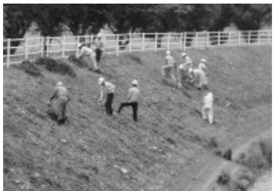
除草作業を行う上三川町建設事業協同組合員
