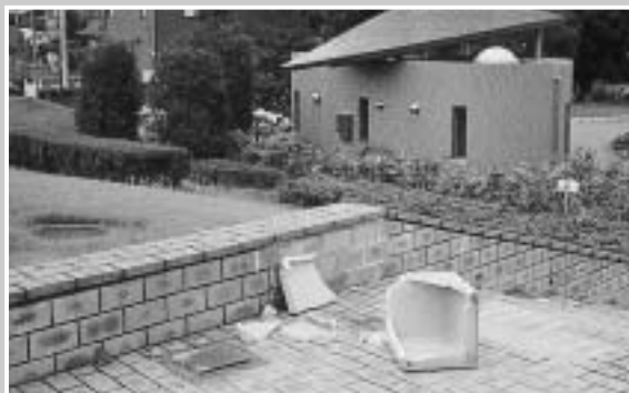
壊された公園のベンチ
